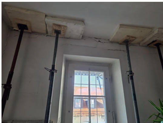
Abgestützte Decke im ersten Stock
